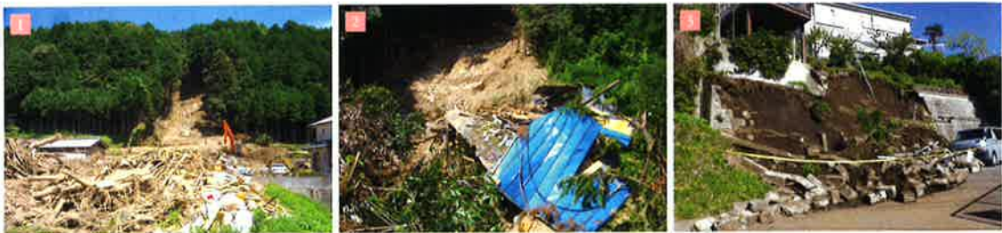
■ 2010年、岐阜県の東濃地域を中心に発生した土砂災害の様子。土石流が発生し、谷出口の民家を直撃、住民3名が被災した。同地域で崖崩れも発生したが、住民が事前に崖の異常に気付いて避難したため、助かった。■ 2013年首都圏で発生した2段擁壁の崩壊例
